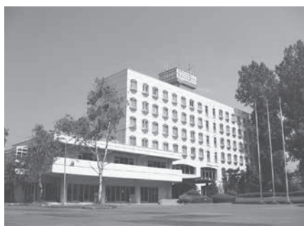
(1) 4号館(こぶし会館)
