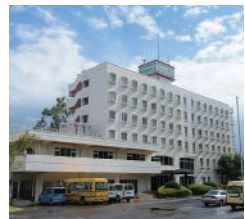
4号館(こぶし会館)
